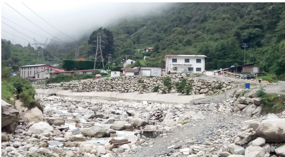
Figura 35. Central hidroeléctrica Cuticucho en Valle de Zongo, 2020.
