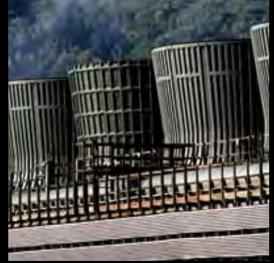
Apoyo a la producción de energía termoeléctrica
