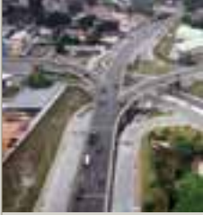
Viaducto Antônio de Andrade Simões, bajo el Programa de Infraestructura Urbana y Ambiental del municipio de Manaus.
