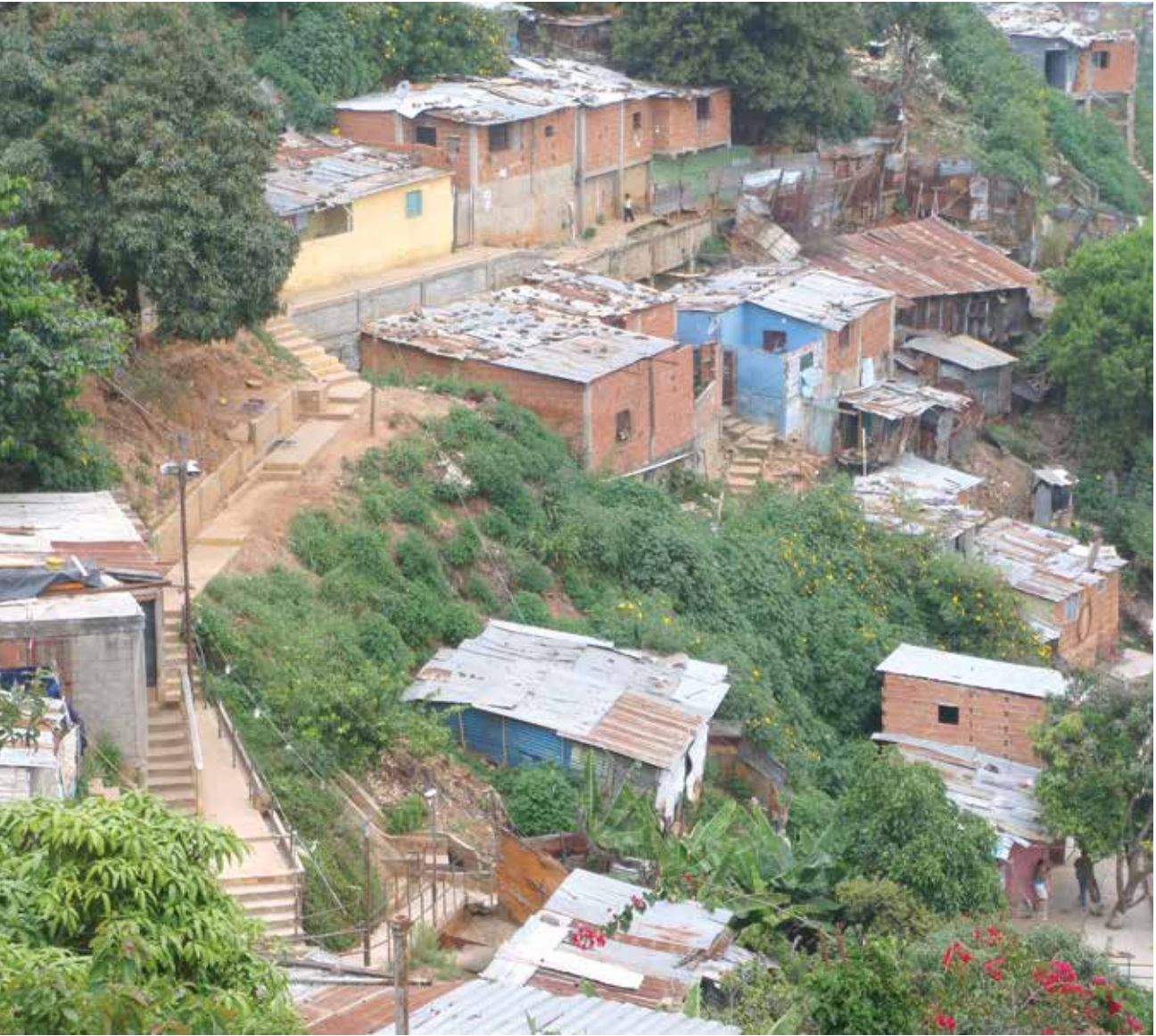
Vista del espacio a ser intervenido
