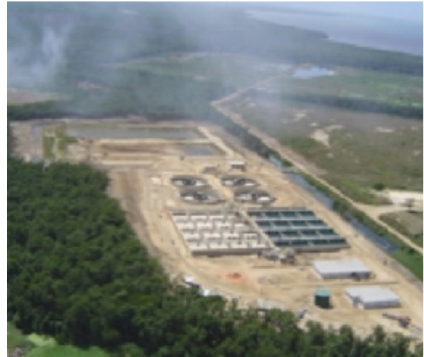
Figura 3.4. La Planta de Tratamiento de Aguas Residuales de Beetham in Puerto España es objeto de este caso de estudio
