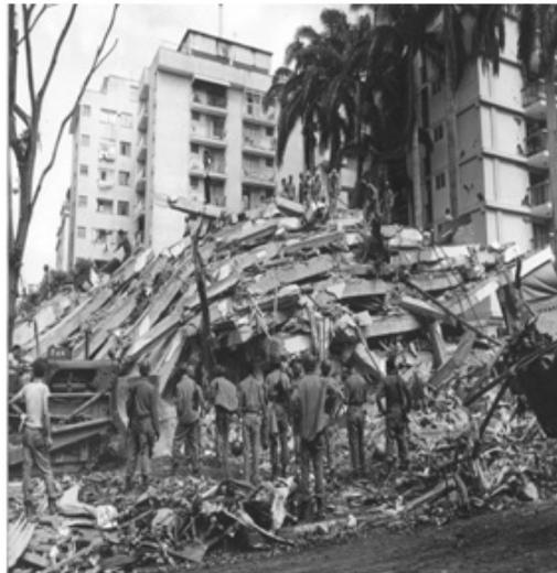
**Figura 6.1** El edificio Mijagual antes y después de sismo de Caracas de 1967. Nótese la interrupción de las paredes de mampostería en el nivel inferior de la fotografía de la izquierda (a) Antes (b) Después (Fotografías: Archivo FUNVISIS)
