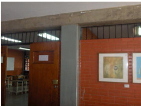
**Figura 7.6** Columna corta generada por la interrupción de la pared en un salón de clase de una escuela (Fotografía: Oscar López)
