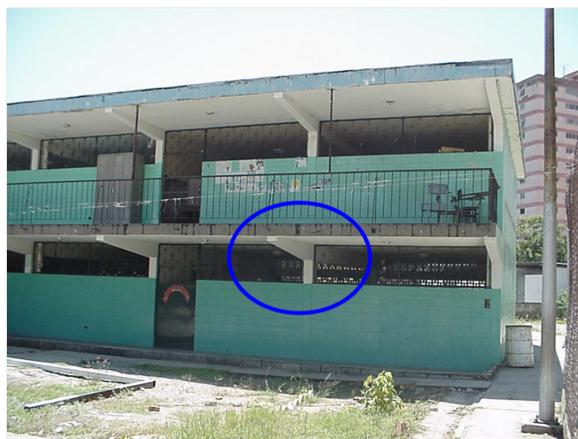
**Figura 6.4** Falla en columna corta de la escuela Valentín Valiente. El círculo destaca en (a) Escuela Valentín Valiente. Columna colapsada, y (b) Columna similar en escuela idéntica (Fotografías: (a) Archivo FUNVISIS, (b) Oscar López)
