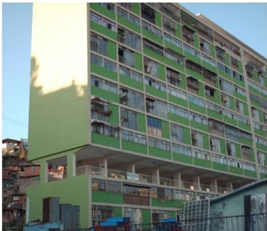
**Figura 6.3** Piso blando en un entrepiso intermedio de un edificio en Caracas (Fotografía: Oscar López)
