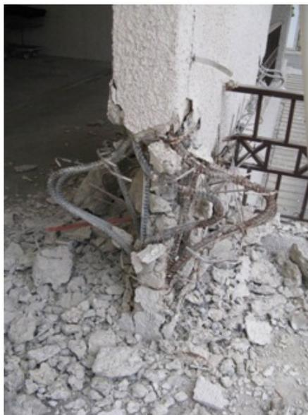
**Figura 1.3** Fuentes comunes de vulnerabilidad sísmica presentes en edificaciones antiguas. (a) Ausencia de planos resistentes en una dirección horizontal (b) Insuficiente refuerzo transversal e inadecuado doblado de ganchos en columna (Fotografías: (a) Oscar López, (b) Fuente (R. Boroschek).
