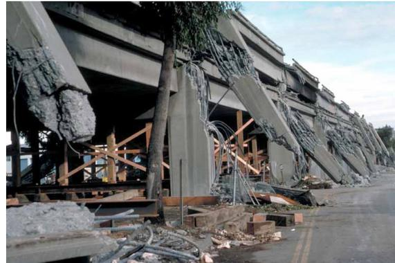
**Figura 1.2** Viaducto de Ciprés derrumbado en Estados Unidos durante el Sismo de Loma Prieta, California, 1989, que había sido diseñado para resistir terremotos. (Fotografías: H.G. Wilshire, *U.S. Geological Survey*).
