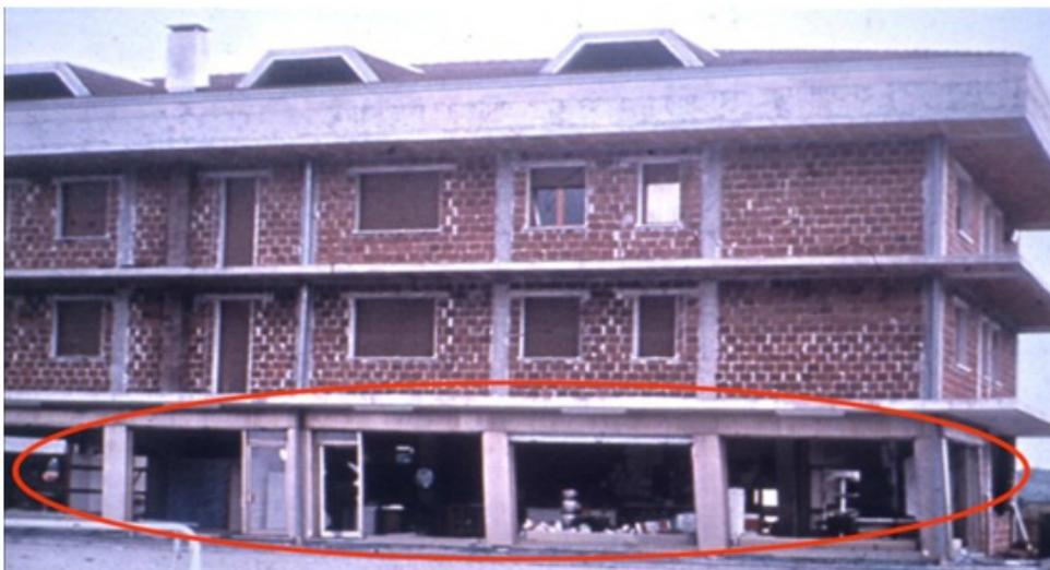
**Figura 6.2** Formación de un potencial modo de colapso por la presencia de un piso blando inducido por la terminación de las paredes de relleno (Fotografía: OPS-OMS, 1999)
