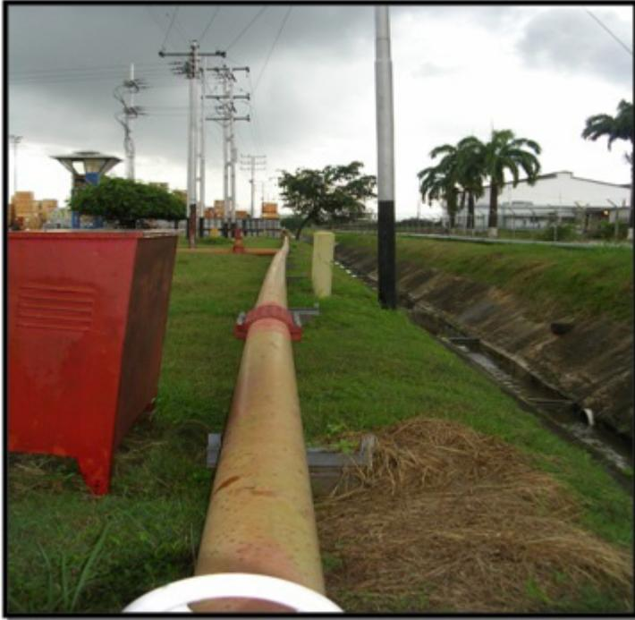
Figura 4.7 Desplazamiento Dextral de una Tubería de Servicio (Fotografía: José Grases)
