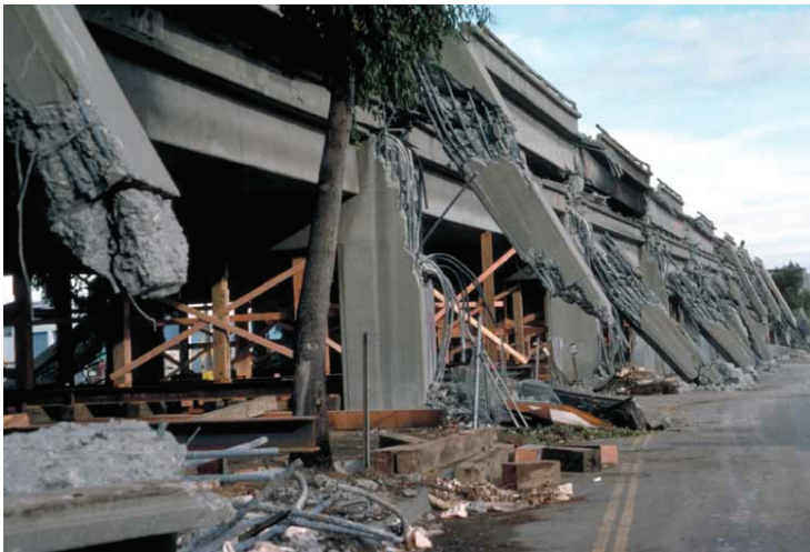
Figura 3.17 Terremoto de Loma Prieta (1989). La falta de un confinamiento adecuado en las columnas y la debilidad de las juntas, provocaron el colapso del puente (Cypress Viaduct) (Fotografía: H.G. Wilshire, USGS). http://commons.wikimedia.org/wiki/File:022srUSGSCyprusVia.jpg
