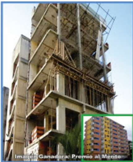
Figura 6.10 Rehabilitación y readecuación sísmica de edificios en Venezuela (Fuente: ALCONPAT, 2010). http://ivconpatnacional.blogspot.com/
