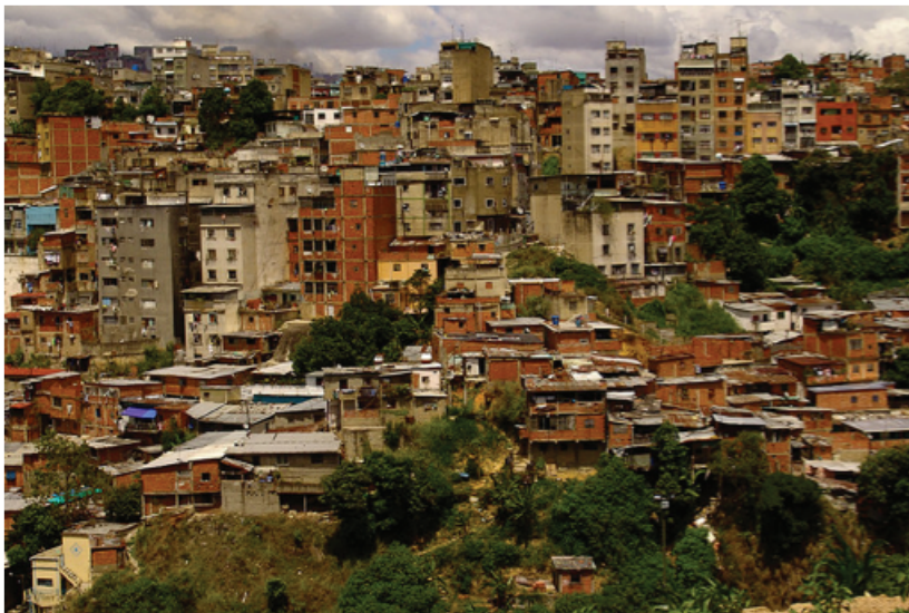
Figura 2.25 Viviendas en asentamientos informales de Caracas, Venezuela. Mala estructuración, bajo control de calidad, sin criterios técnicos, materiales no estructurales, terrenos de fundación no adecuados: son estructuras muy vulnerables ante sismos (Fotografía: Cristian Borquez).
