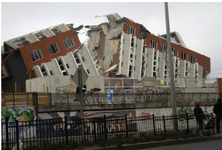
Figura 2.21 Terremoto de Chile, 2010. Licuefacción del suelo. Edificio destruido en Concepción (Fotografía: Claudio Núñez). http://commons.wikimedia.org/wiki/File:2010_Chile_earthquake_-_Building_destroyed_in_Concepci%C3%B3n.jpg
