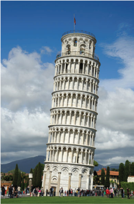
Figura 2.19 La torre de Pisa comenzó a inclinarse desde el inicio de su construcción en 1173, por inestabilidad del suelo y por tener fundaciones débiles. Fue estabilizada y reabierta al público en 2008. La altura de la torre es de unos 55 metros desde la base y su peso se estima en 14700 toneladas. Puede observarse como su arquitectura guarda antiguos principios de estructuración, como armonía y proporcionalidad (Fotografía: Saffron Blaze). http://commons.wikimedia.org/wiki/File:The_Leaning_Tower_of_Pisa_SB.jpeg
