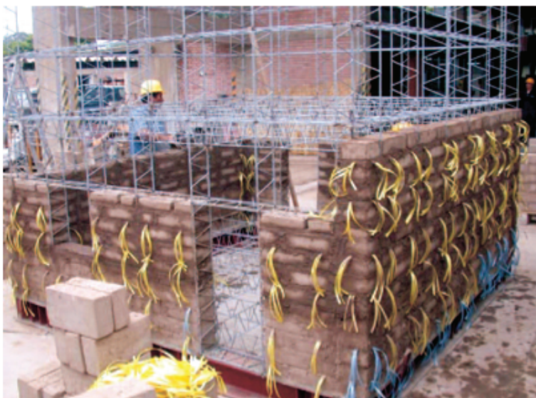
Figura 6.4 Construcción de un prototipo de edificación de adobe para ensayo en laboratorio en la Universidad Pontificia Católica, Lima, Perú (Fuente: B. Orta et al., 2009).
