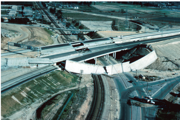
Figura 3.2 Terremoto de San Fernando, Estados Unidos de América (1971). Colapso de paso elevado en la autopista (Fotografía: Reuben Kachadoorian, USGS).
