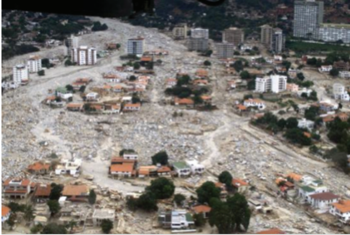
Figura 1.9 Lluvias de Vargas, Caraballeda (1999) (Fotografía: Smith Lawson, US ACE, USGS). http://commons.wikimedia.org/wiki/File:Caraballeda_1999_Deposits_and_Damage.jpg
