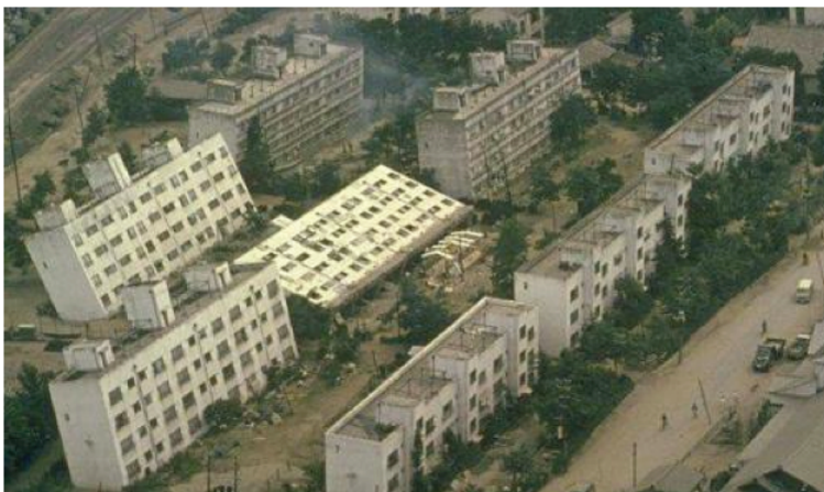
Figura 5.4 Efectos de licuefacción de suelos. Terremoto de Niigata, Japón, 1964 (Fotografía: UNGTSS). http://commons.wikimedia.org/wiki/file:liquefaction_at_niigata.jpg
