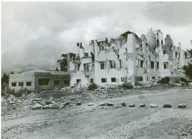
Figura 3.6 Terremoto de Ambato, Ecuador (1949). Ruinas de un hospital (Fotografía: G. E. Lewis, USGS). http://commons.wikimedia.org/wiki/File:Ambato_Earthquake_-_Ruined_Hospital.jpg .
