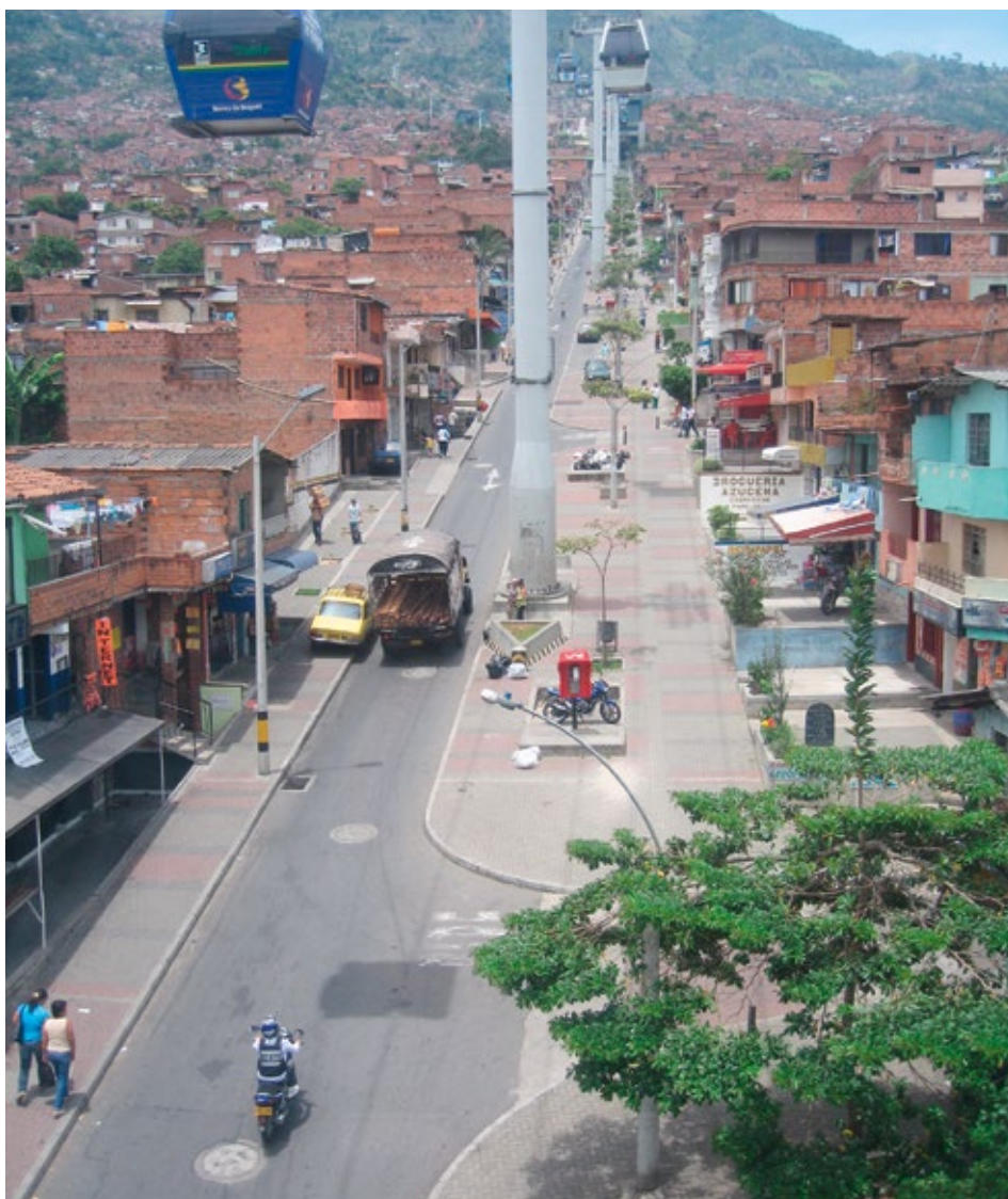
Imagen 6.2 - La colocación de los postes del Metrocable en la Calle 34 han dado prioridad al peatón
